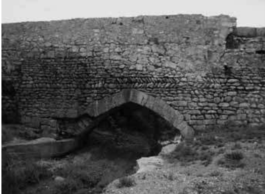
Detall de l'arc apuntat d'època medieval sobre el Torrent de l'Almatella, de l'aqüeducte d'origen romà conegut com Pont de les Caixes.
