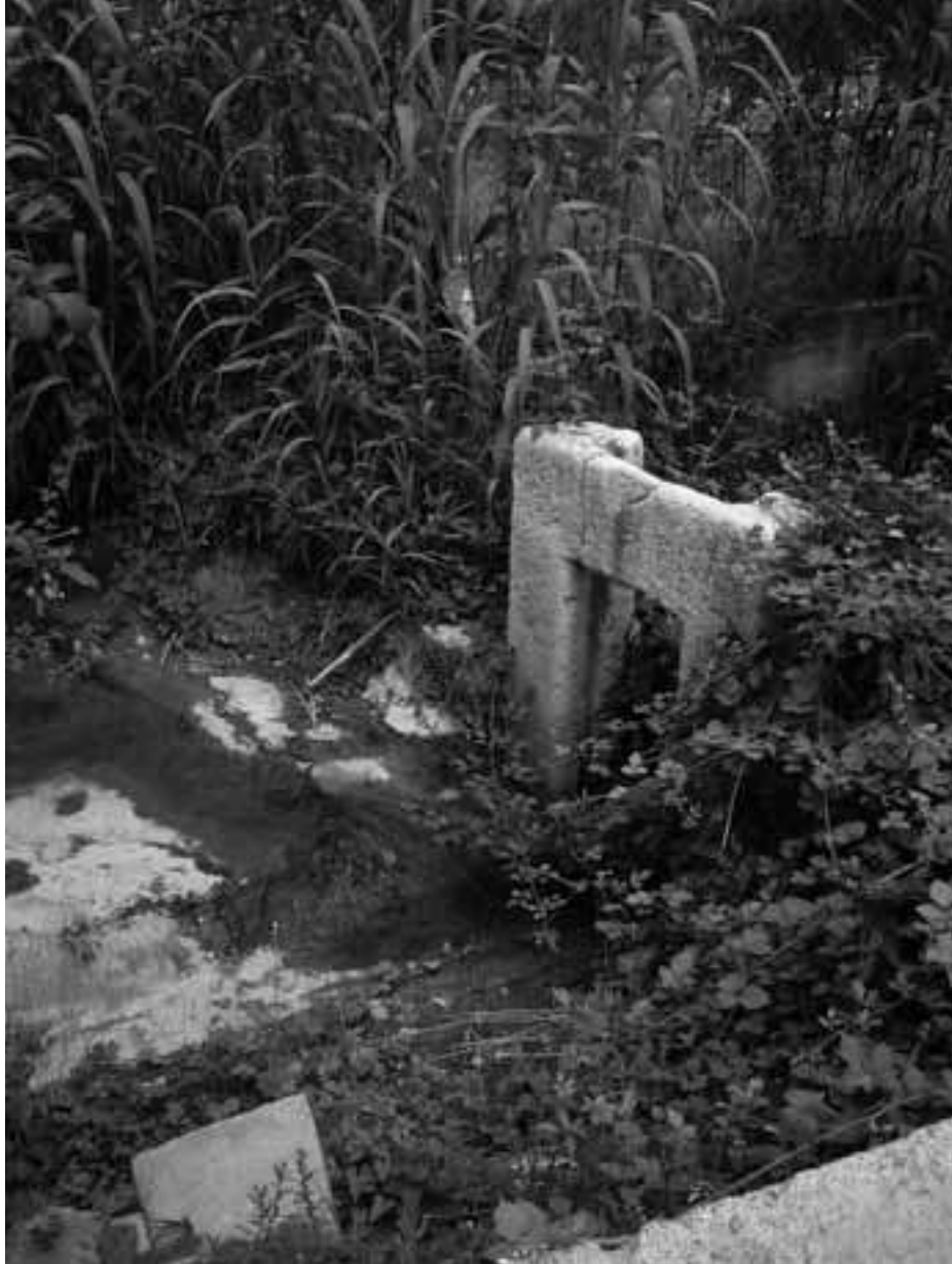
Detall d'un trestellador de la Sèquia dels Molins, davant el Molí de Constantí, que exhibeix tres escuts de l'arquebisbe Ènnec de Vallterra (1380-1407).
