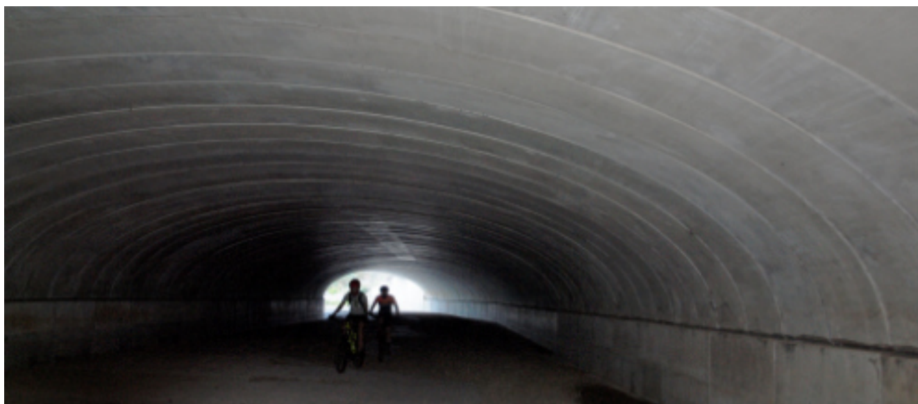
Túnel de l'aeroport.
